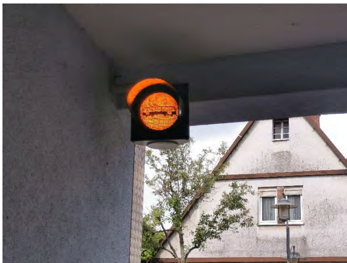
Abbildung 1: Haltesignal in TG-Ausfahrt
