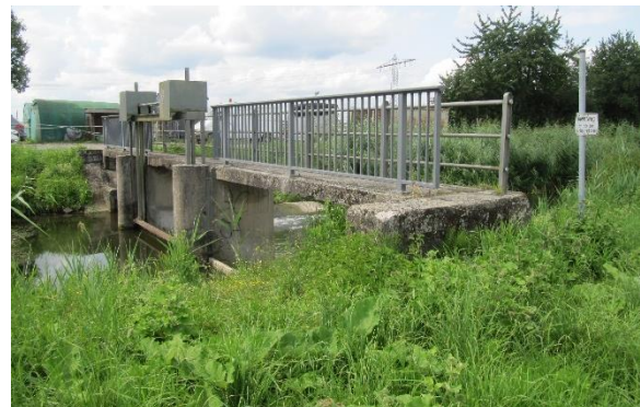
Abbildung 118: Regelungsbauwerk an der Pfinzkorrektur südlich der Einmündung des Neuen Kanals (Foto: Stefanie Breunig)
