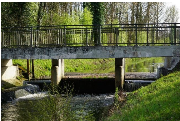
Abbildung 119: Regelungsbauwerk an der Pfinzkorrektur östlich Schloss Stutensee (Foto: Stefanie Breunig)
