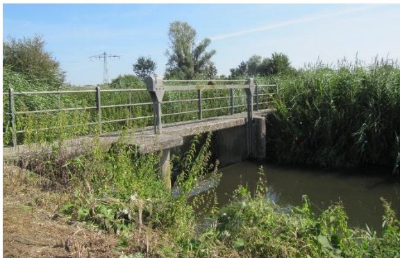
Abbildung 117: Regelungsbauwerk am Neuen Kanal (Foto: Stefanie Breunig)
