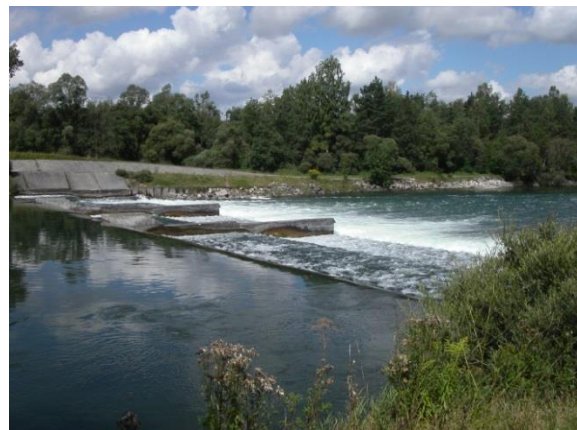
Sohlstufe 4 (nördlich des Weitmannsees)
