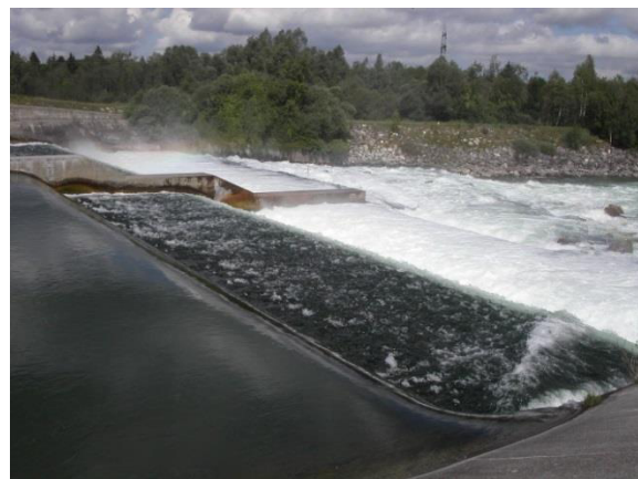
Sohlstufe 1 (nördlich des Auensees)
