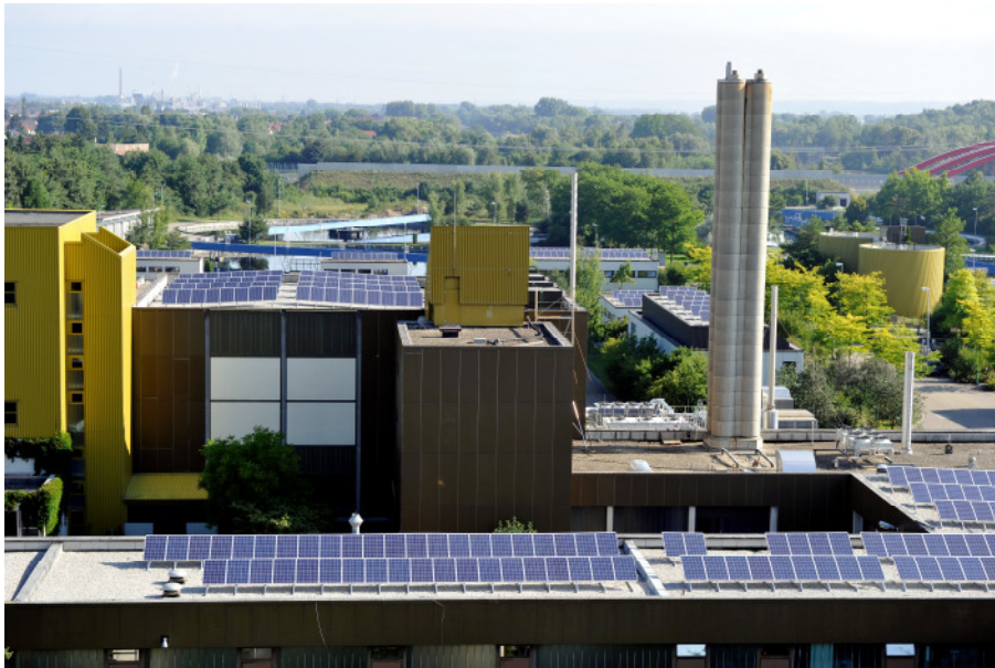
PV-Module auf den Gebäudedächern im Klärwerk Augsburg
