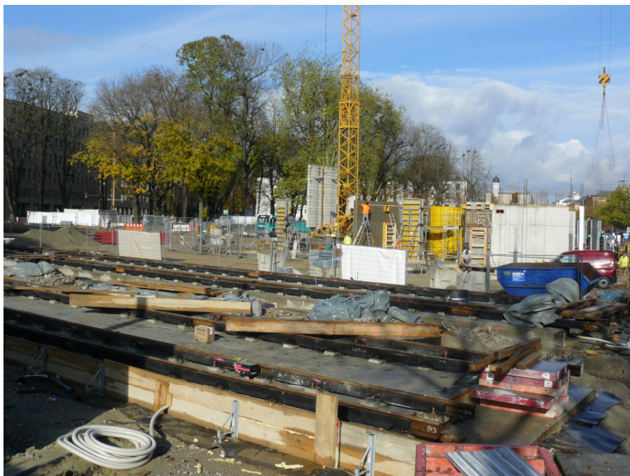
Baustelle Königsplatz, mit Blickrichtung nach Norden im November 2012
