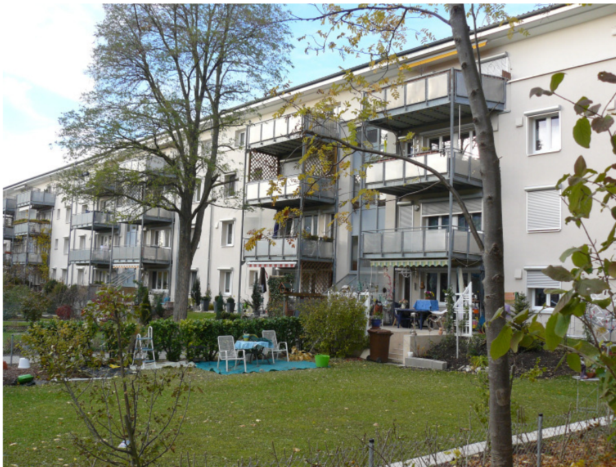
Sanierte Häuserzeile in der Deutschen- baurstraße, Augsburg- Pfersee
