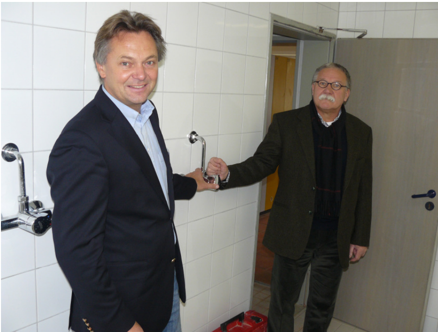
Nach der Montage der wasser- und energiesparenden Duschen: Jakob Schweyer und Alfred Schneider vom TC Augsburg e. V.
