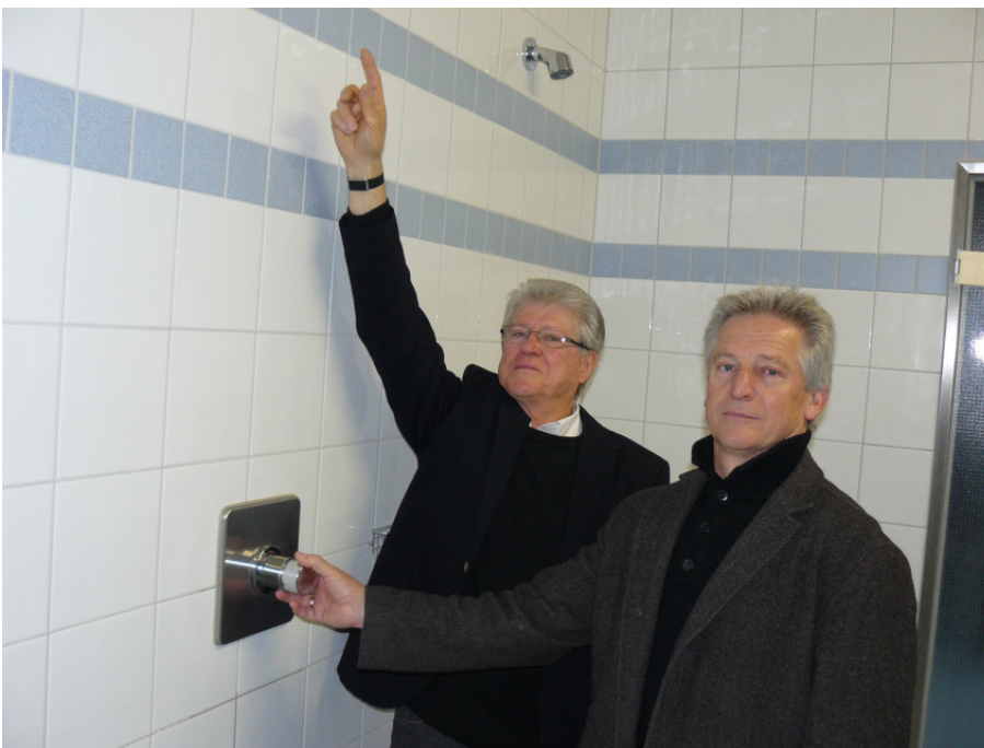
Beim TV Augsburg 1847 e. V. wurden 49 Duschanlagen Wasser sparend umgerüstet. Günter Löhnert und Rudolf Engelbrecht zeigen das Ergebnis.
