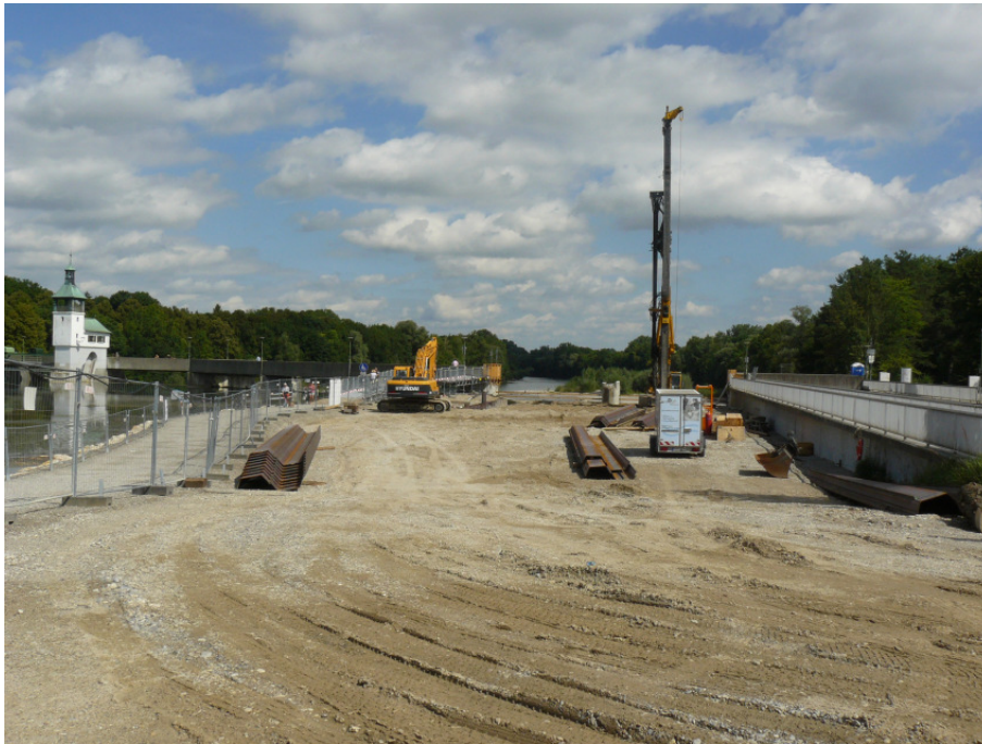
Investitionsobjekt aus dem Bürgerdarlehen „Wasserkraftwerk im Hochablass“, Baustellenbild vom 8. August 2012
