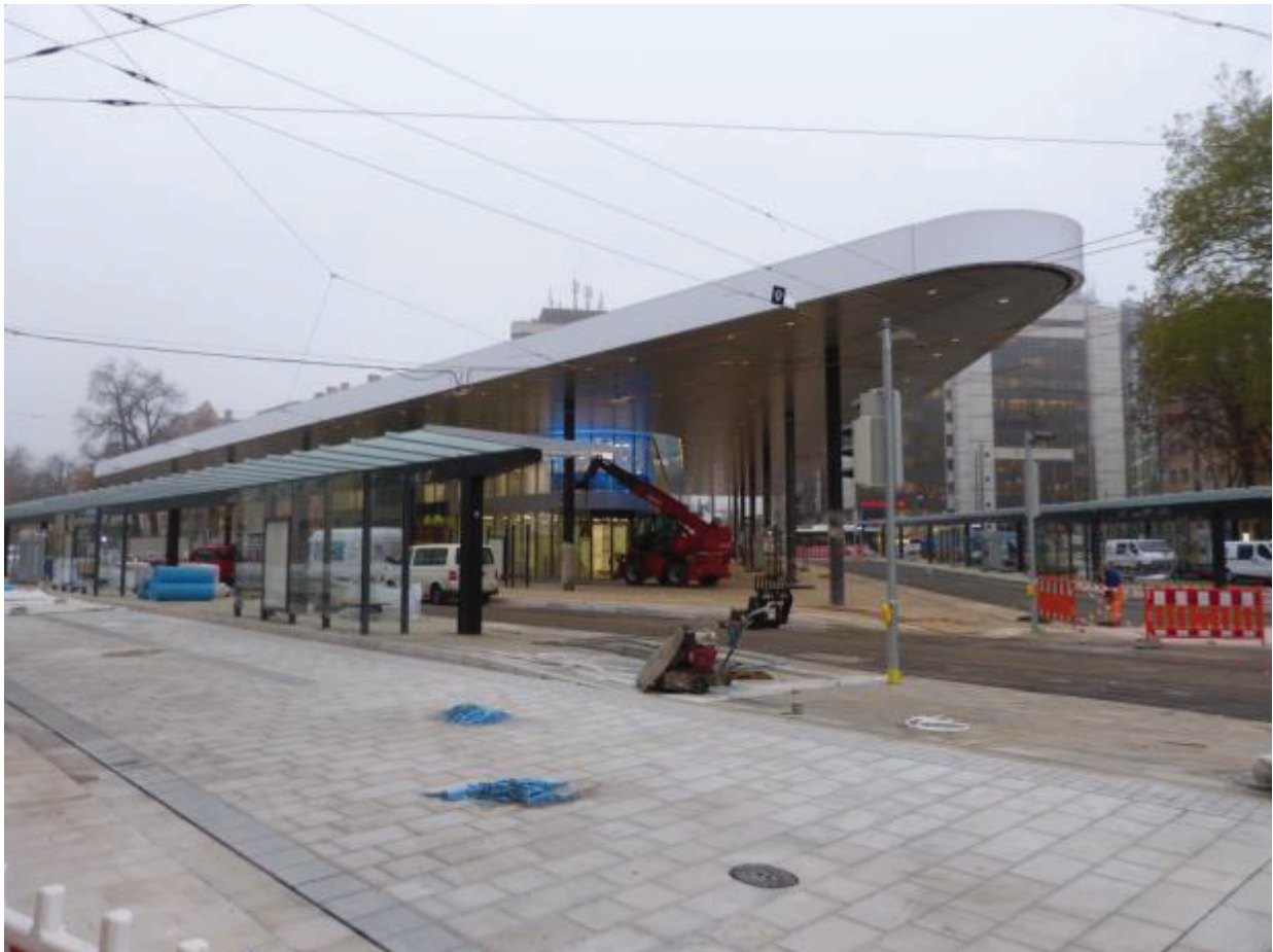
Neues Haltestellendreieck am Königsplatz kurz vor der Fertigstellung (Bild vom 15. April 2013)
