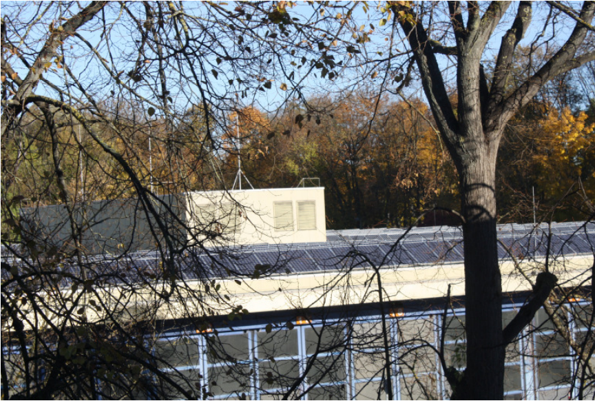
Photovoltaikanlage „Omni-busbetriebshof“. Die 400 Solarmodule erzeugen seit dem Jahr 2009 umweltfreundlich Strom.
