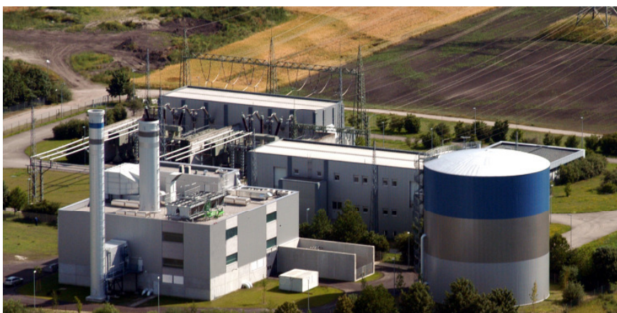
Modernisierung der Kraft-Wärme-Kopplung durch den Bau der Gasturbinenanlage GT-Ost (Erdgas)
