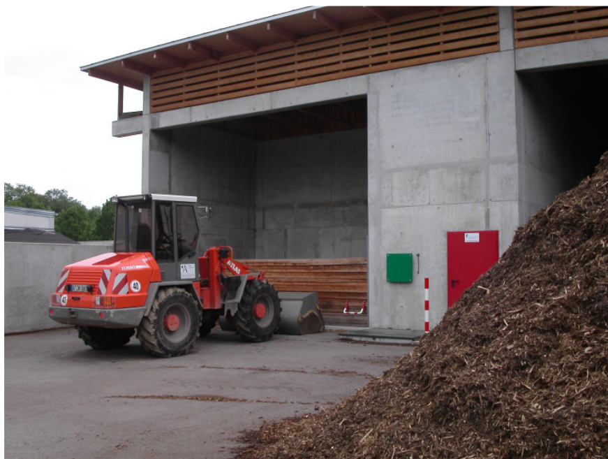
Brennstofflagerung der Holzhackschnitzelanlage im Botanischen Garten
